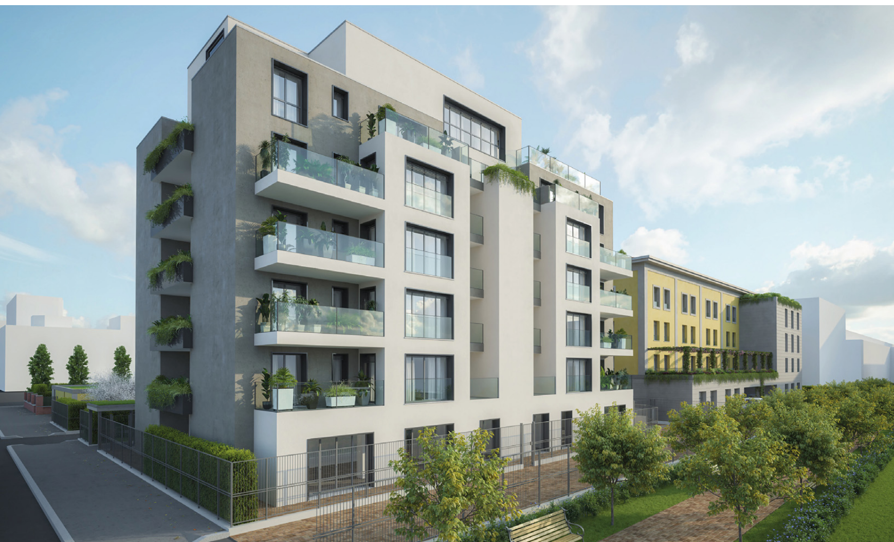
Vista dell'edificio dell'APA.
