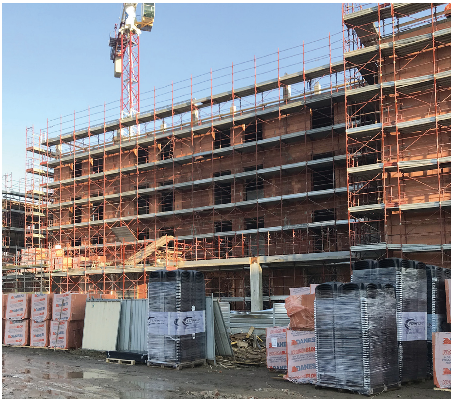
Il cantiere dell'edificio dell'APA.
